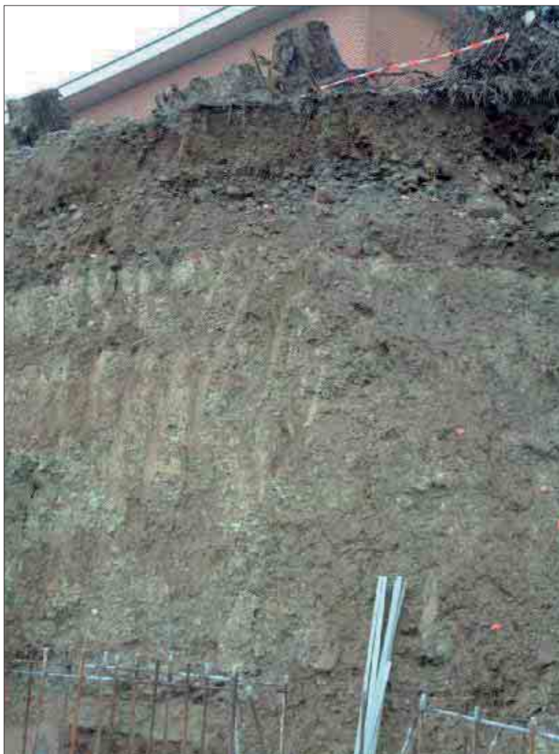
Foto 1 - Affioramento del "Complesso caotico della Valle Versa". Si nota, al tetto, la presenza di uno strato di riporto, in parte ghiaioso, di spessore metrico e sullo sfondo lo stabilimento Favretto.
