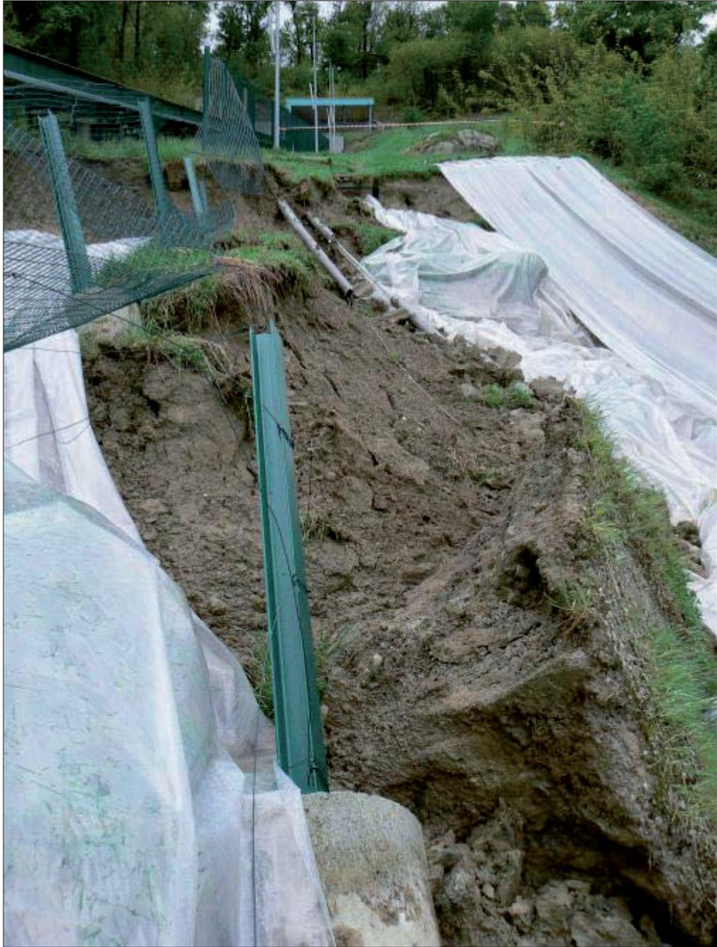
Movimento franoso innescatosi a seguito delle intense precipitazioni piovose del 25÷28/04/2009 che ha coinvolto un tratto delle le strutture dell'impianto a fune di risalita all'osservatorio astronomico di Pino Torinese
