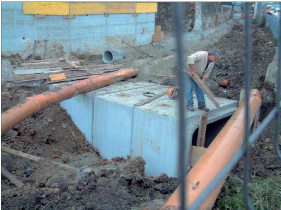
Foto 4 – costruzione della struttura scatolare a monte della Via Chieri e suo collegamento con il sottopasso stradale. Si nota sullo sfondo la tubazione di raccolta delle acque che saranno immesse nel canale.
