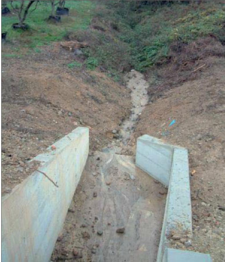
Foto 2 – Sbocco della struttura scatolare di sottopasso della rotonda viaria in costruzione con innesto nel fossato preesistente
