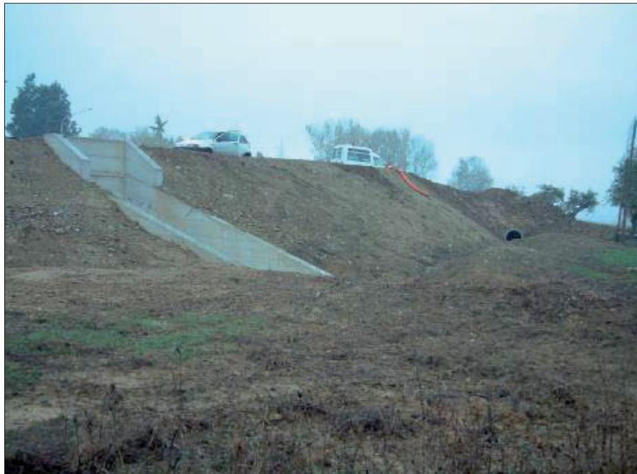
Foto 3 – scarpata di valle della rotonda viaria in costruzione con sbocco della struttura scatolare di sottopasso stradale
